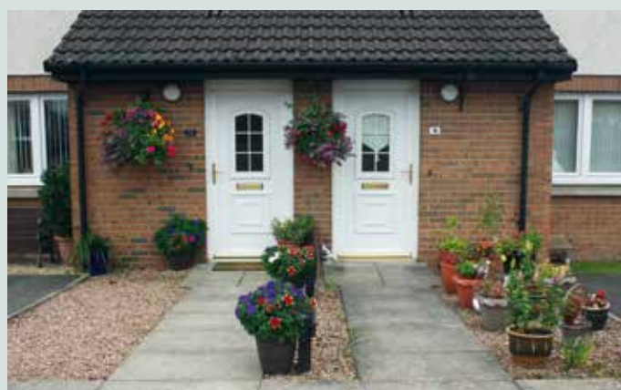
De Moray Court, Cornton
